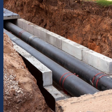
管路 約60万km
